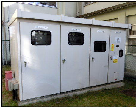
沓掛小学校の高圧受電設備
