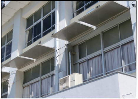
豊田市の小学校に設置されているひさし
