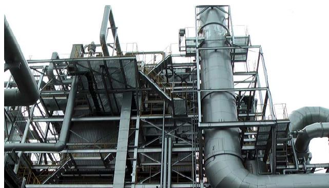
真庭バイオマス発電所
