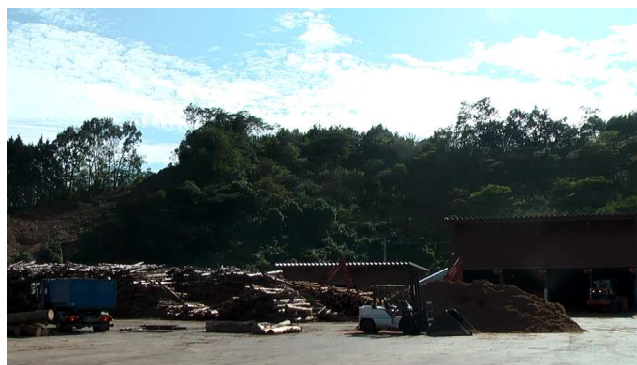
真庭バイオマス集積基地第二工場
