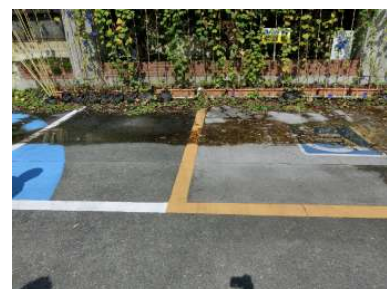
右が熱交換塗料施工面
