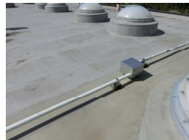
奥が熱交換塗料施工面
