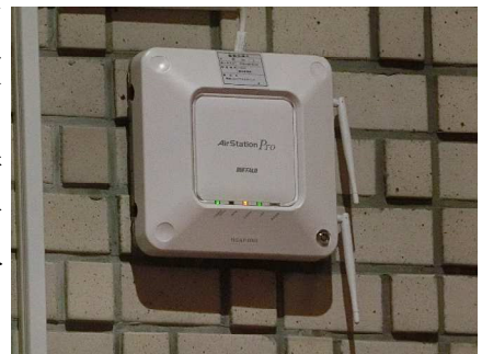
議場内の無線 LAN アンテナ
