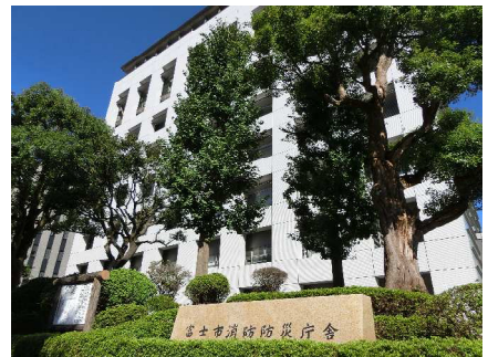
富士市・富士宮市消防指令センターがある富士市消防防災庁舎
